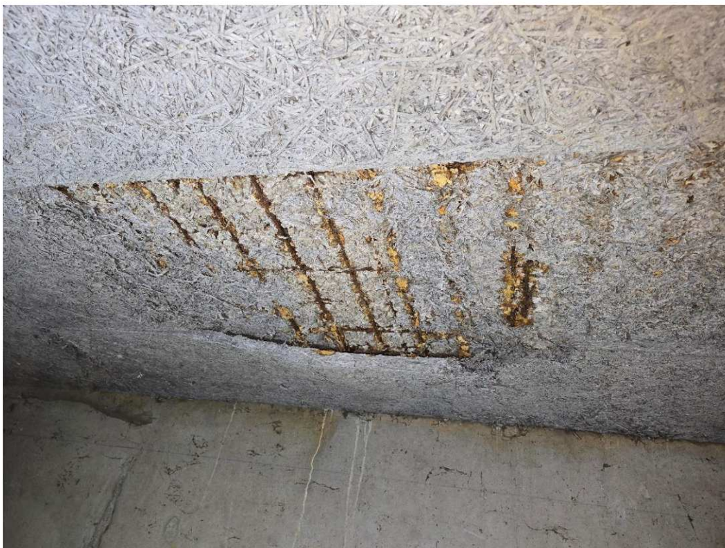
Photo n° 3 : Armatures en sous-face de dalle
