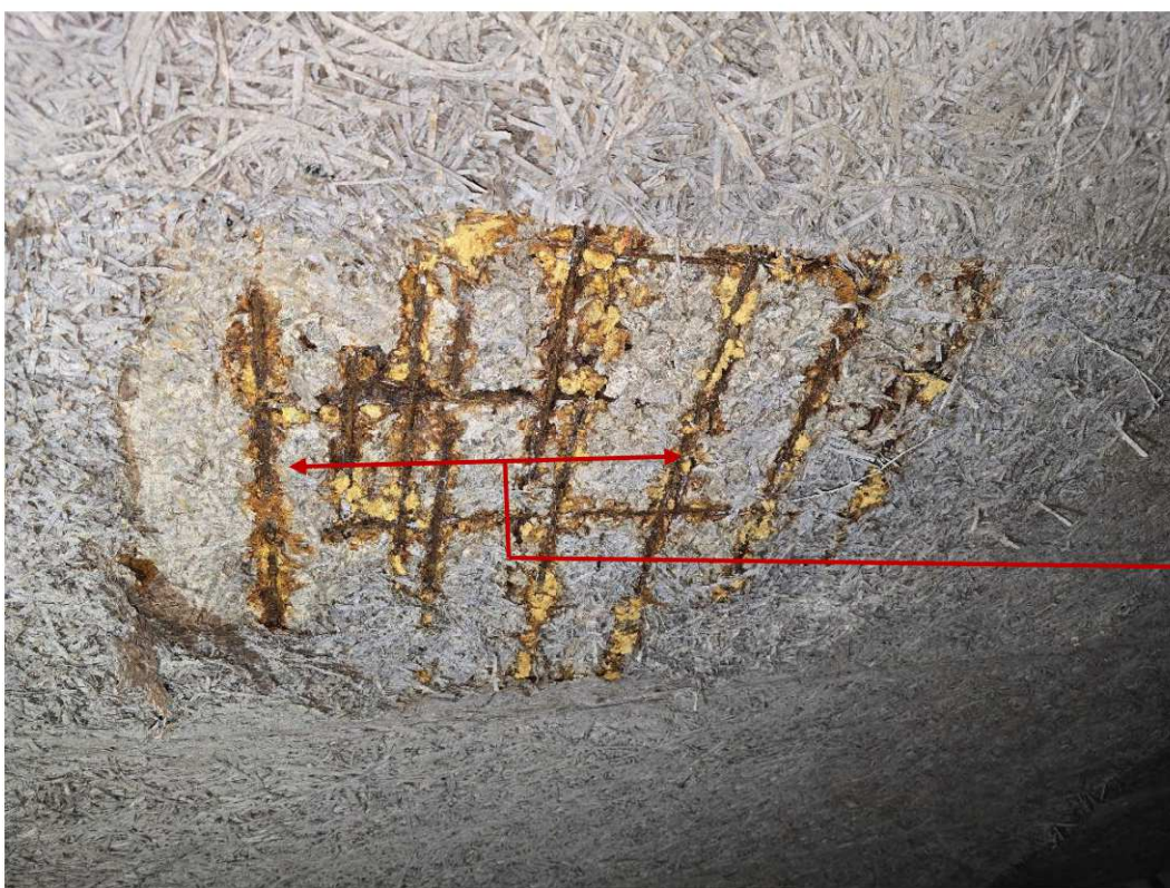
Photo n° 4 : Zone de recouvrement d'armatures
