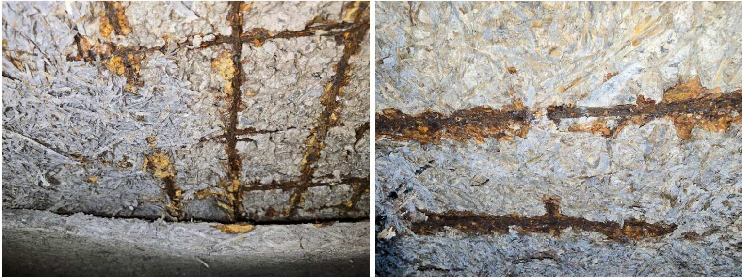
Photos n°5a/5b : Zoom sur les armatures inférieures (décollement du fibrastyrène en sous-face)
