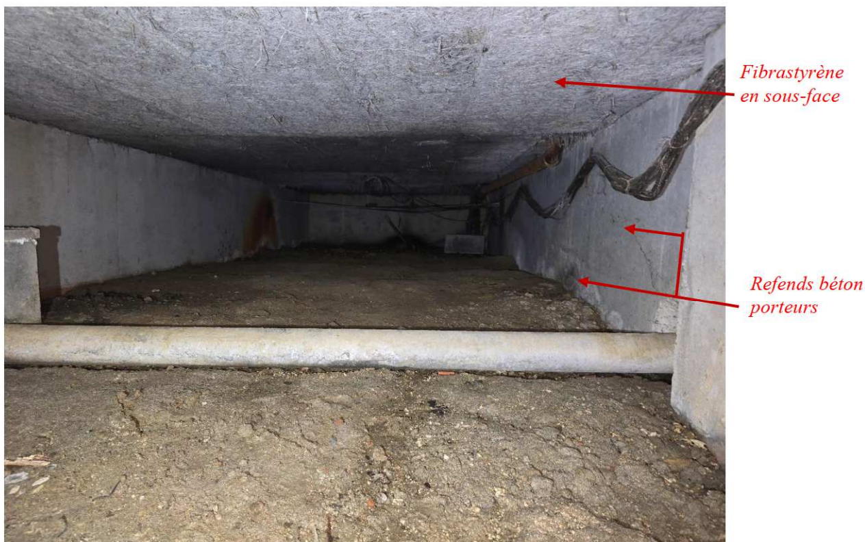
Photo n° 1 : Vue d'une travée type
